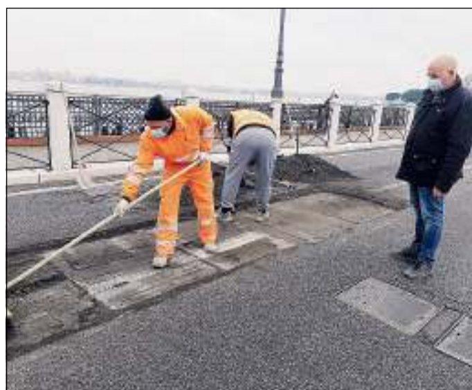
Sarà un intervento di sistemazione del manto stradale
